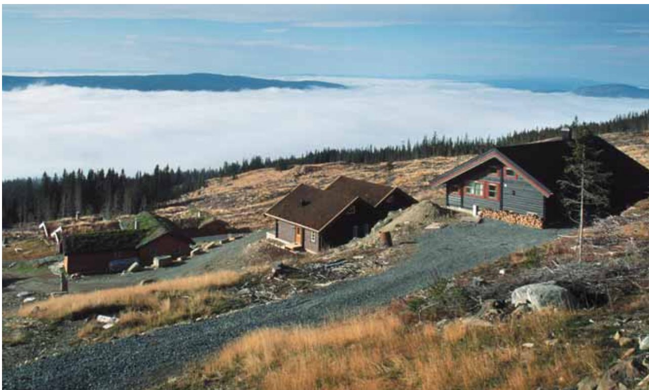
I stedet for å hogge ut all skogen, som her, bør hytter, veger, ledninger og vegetasjon planlegges i sammenheng, for å sikre både utsikt og skjerming. Dette er viktig for landskapsvirkningen, men også for å gi skjerming for hyttene og redusert energiforbruk. Foto: Jarle Wæhler, Opplandsbilder
