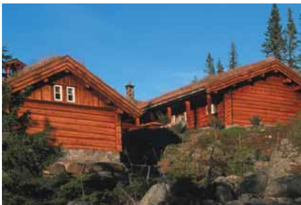
Oppdeling av bygningsvolumet i mindre enheter gjør terrengtilpassning enklere. Fra Hafjell, Øyer kommune. Foto Jarle Wæhler, Opplandsbilder
