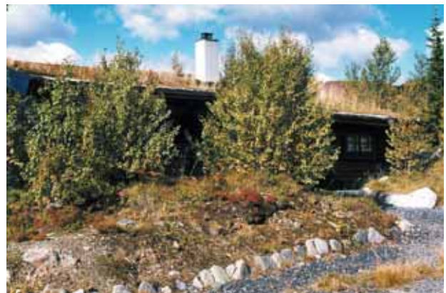
God bruk av terreng og vegetasjon som skjerming mot veg og parkeringsplass
